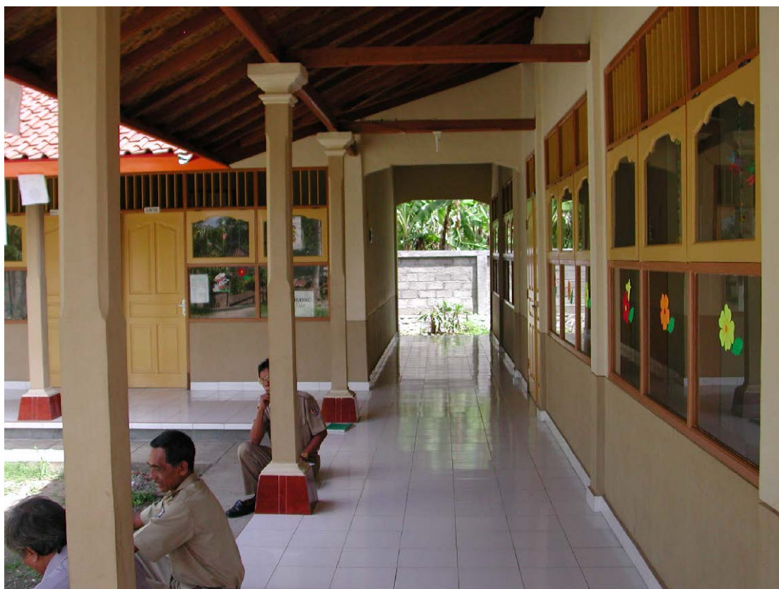
Plate 17: TK Kantika, Peguyangan Kaja, Denpasar Barat
