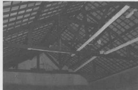
Beri perawatan pada setiap bagian kayu pada rangka atap sebelum dipasang
