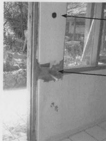
Pipa kabel listrik yang ditanam di tembok ( inbaudoss )
