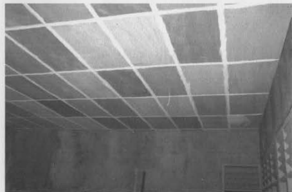
Plafond yang baru dipasang dan akan dicat
