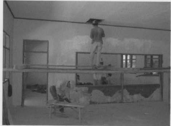
Pengecatan ruang kelas
