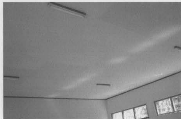
Plafond setelah selesai dicat
