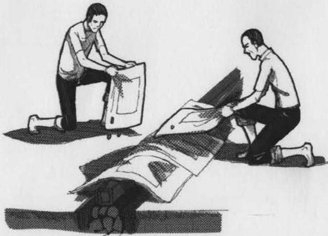
Jaga kelembaban beton dengan menggunakan karung goni basah. Beton yang cepat kering bukan beton yang kuat!
