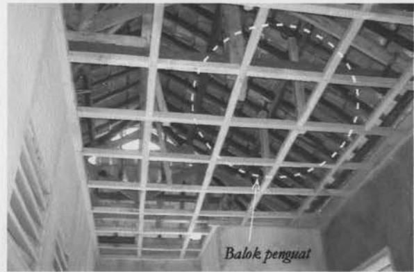
Rangka plafond dengan balok penguat
