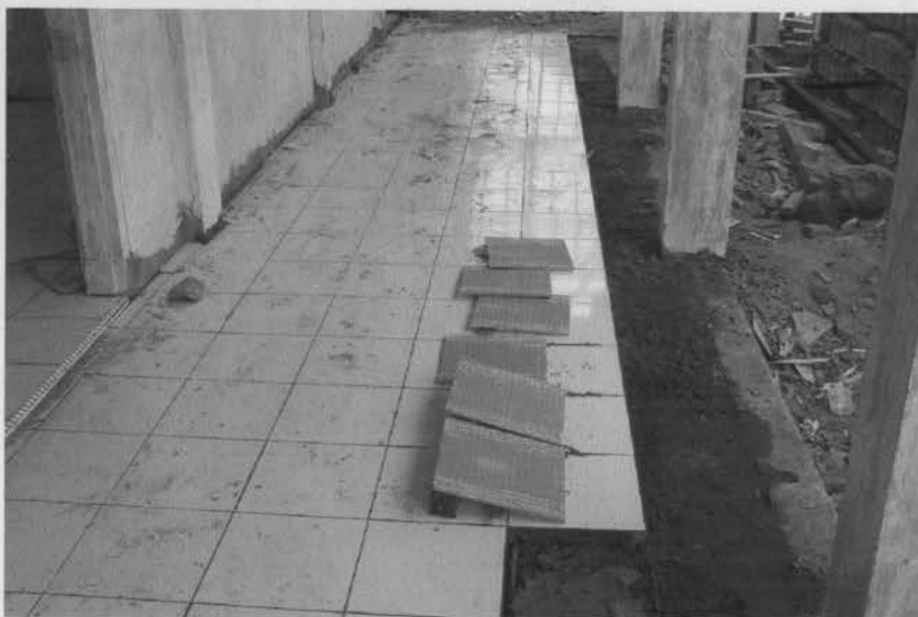
Pemasangan ubin keramik di teras ruang kelas
