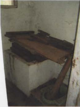
Perbaikan kloset yang tersumbat
