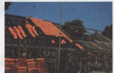
Susunan atap genteng tanah liat yang sedang dipasang
