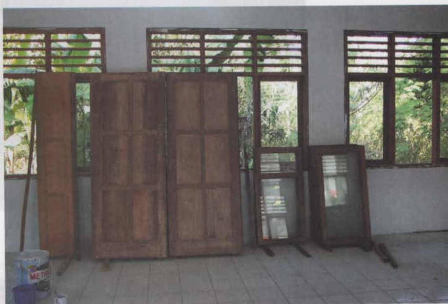
Daun pintu dan jendela yang akan dipasang
