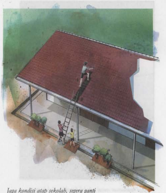
Jaga kondisi atap sekolah, segera ganti atap yang bocor dengan yang baru sebelum air hujan merusak plafond
