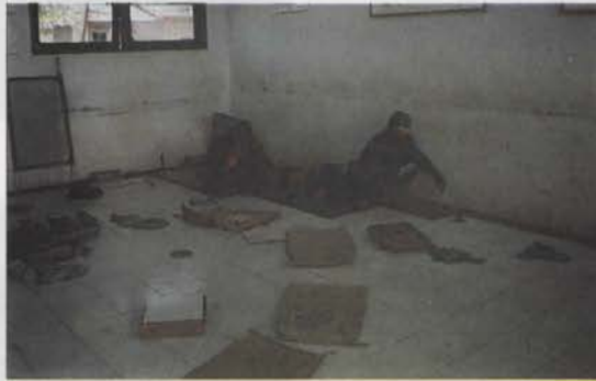
Pemasangan ubin keramik
