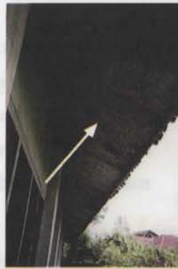
Plafond luar dengan menggunakan anyaman bambu
