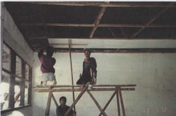
Perbaikan pada langit-langit ruangan
