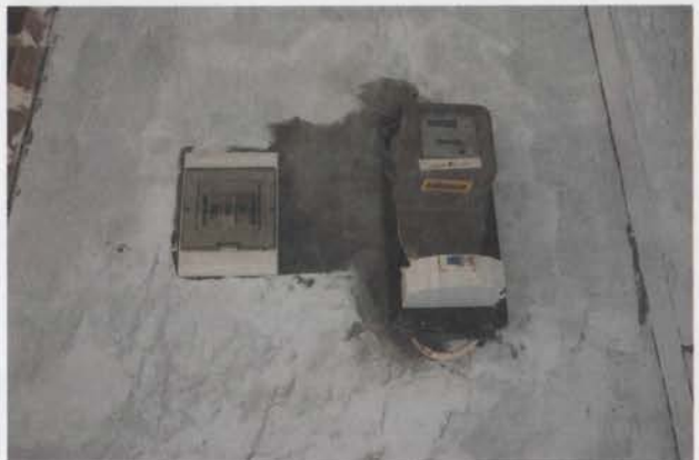
Meteran listrik yang baru dipasang
