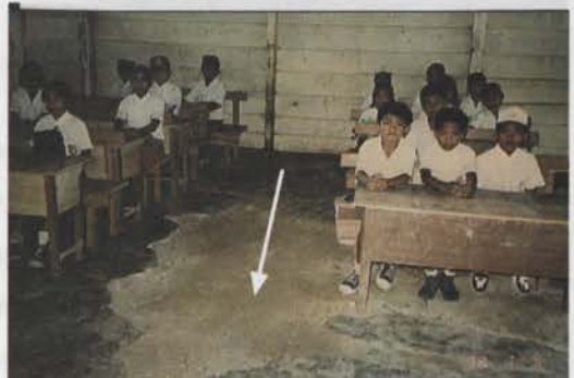
Lantai beton dalam ruangan yang rusak maupun retak
