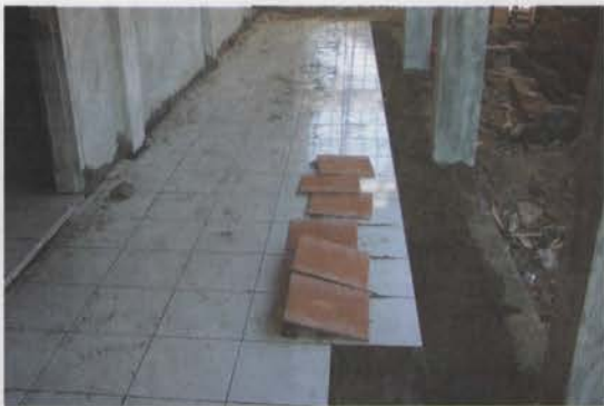
Pemasangan ubin keramik pada beranda
