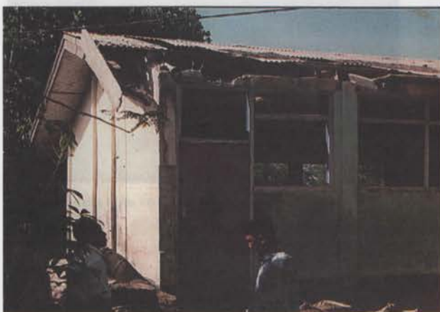
Runtuhnya panel atap metal pada bangunan
