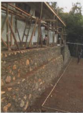
Pembuatan dinding penyangga
