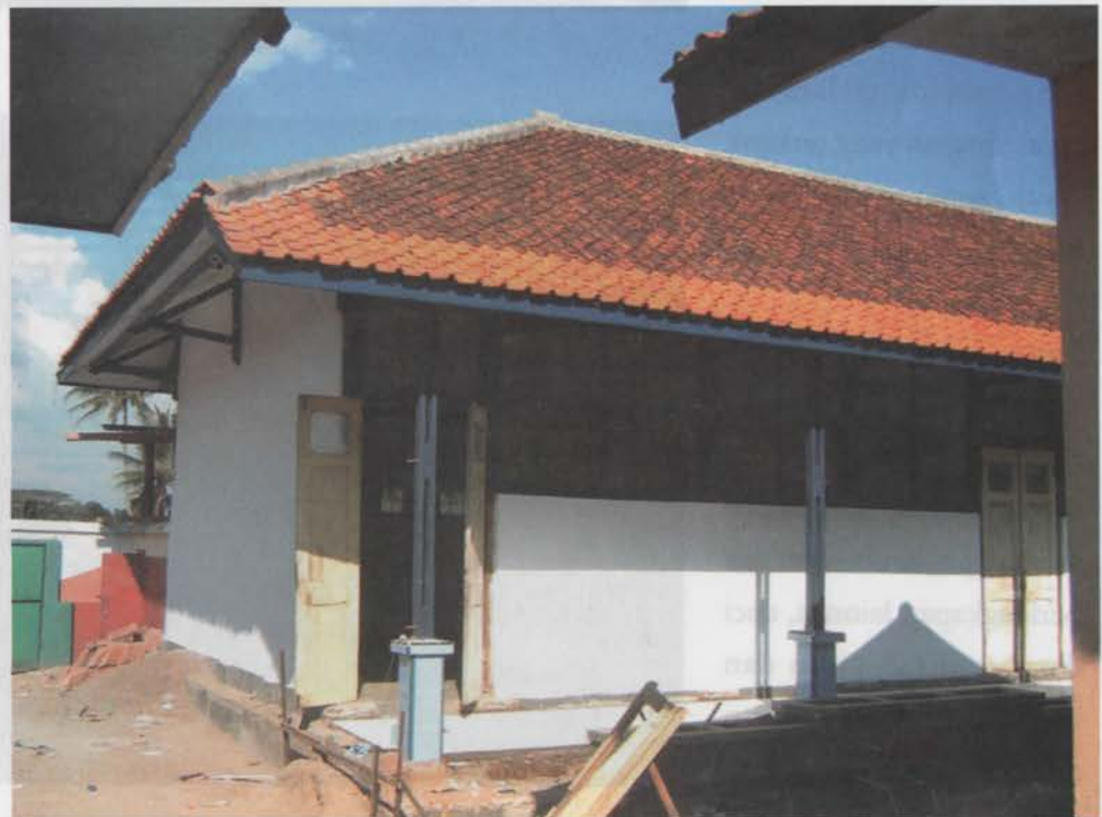
Pintu kayu berdaun ganda yang baru dipasang pada ruang kelas
