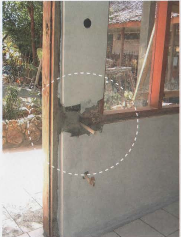
Dinding yang akan dipasang saklar listrik
