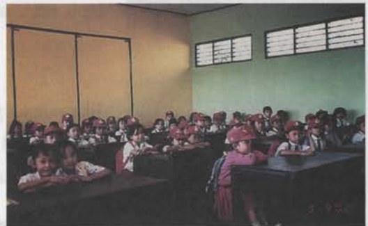
Dinding ruang kelas setelah proses pengecatan
