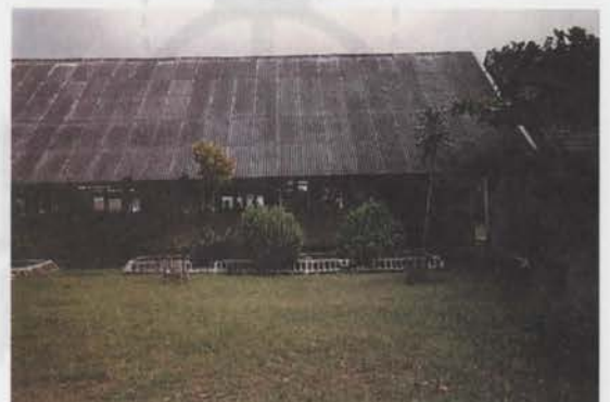
Bangunan sekolah dengan menggunakan atap lembaran asbes
