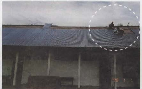
Proses pemasangan lembaran atap metal
