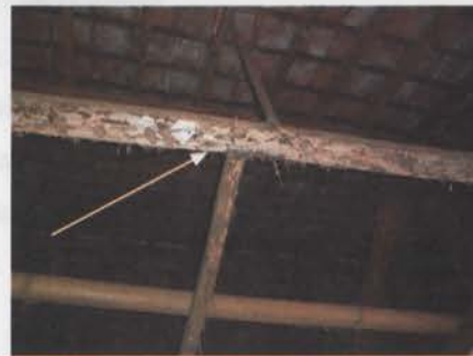
Rangka atap yang terserang rayap
