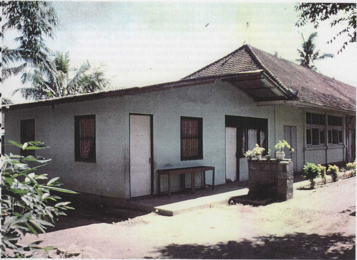
Plate 7: Kindergarten, Desa Kesiman Petilan, Denpasar Timur
